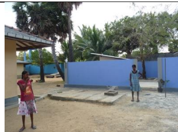
douche(achteraan op foto)- en toiletgebouw
