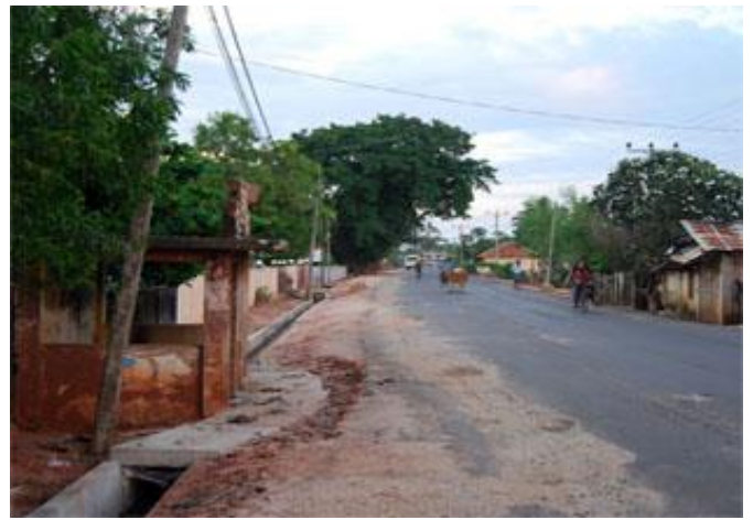
Rechtsboven: het nieuwe drainagekanaal
