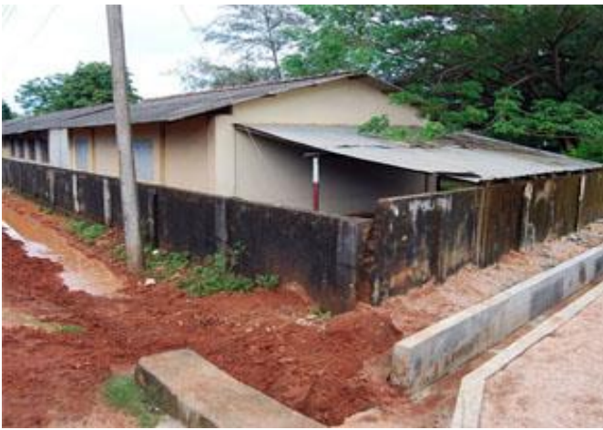
Linksboven: de verhoogde hoofdweg met daarnaast het nieuwe betonnen drainagekanaal
