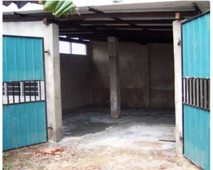
Hier komt één van de twee aangeschafte tractoren met ploeg en aanhanger te staan
