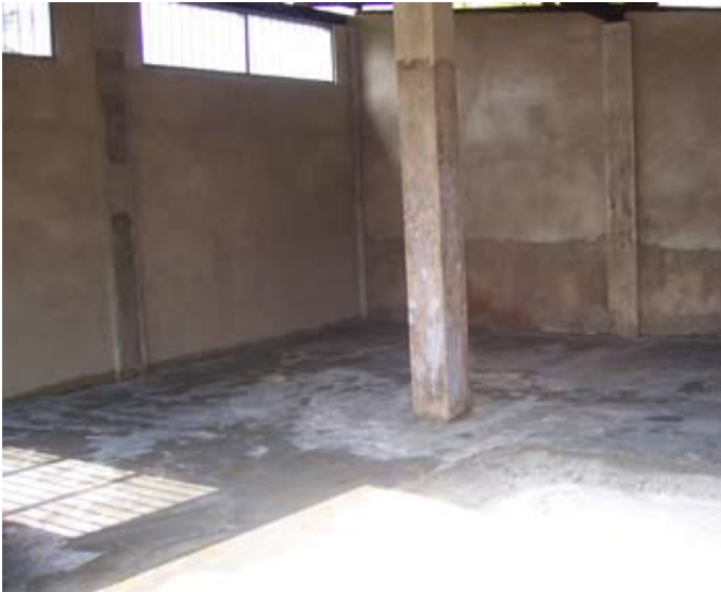
De binnenkant van de eerste garage/schuur
